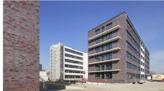
Kurz vor der Fertigstellung: EUROPA-CENTER Hamburg Finkenwerder 2. Bauabschnitt (Stand: März 2015)
