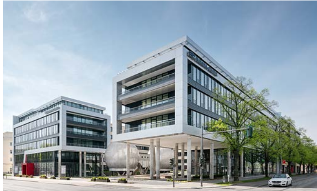
Neubau EUROPA-CENTER Berlin Adlershof an der Rudower Chaussee
