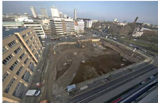
Bauarbeiten gehen wie gewohnt auf der Essener Baustelle weiter - Aufnahme vom 08.03.2016
