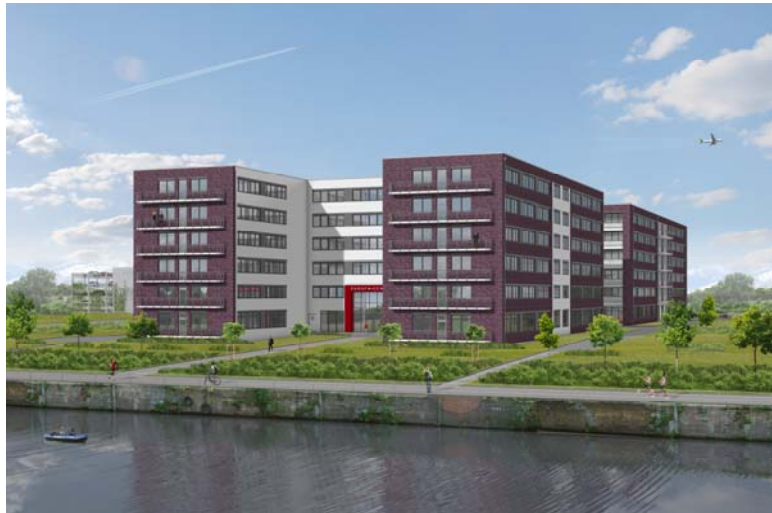
EUROPA-CENTER Hamburg Finkenwerder – 2. Bauabschnitt
