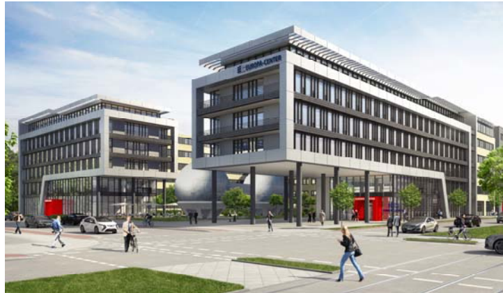
EUROPA-CENTER Berlin Adlershof - 3. Bauabschnitt
