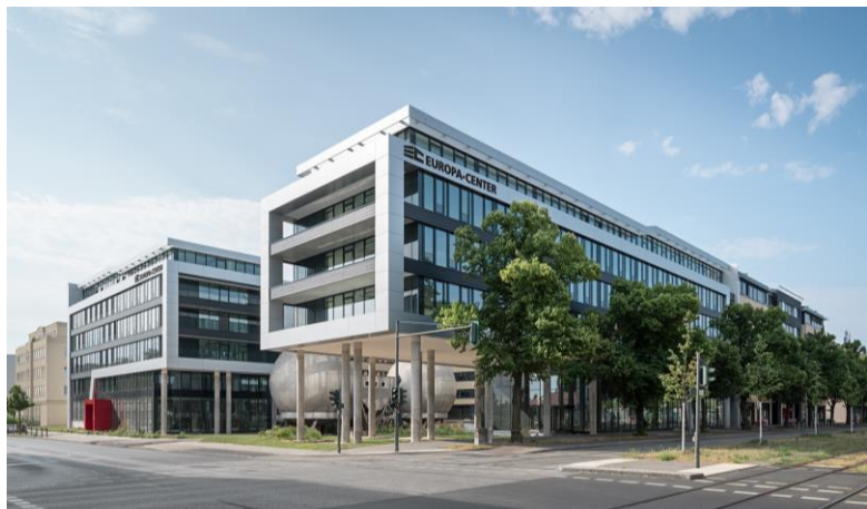
Der fertiggestellte 3. Bauabschnitt vom EUROPA-CENTER Adlershof
